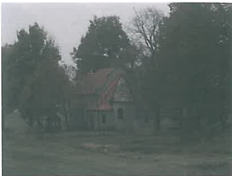
Kaplica widok od strony drogi – zdjęcie grupa projektowa
