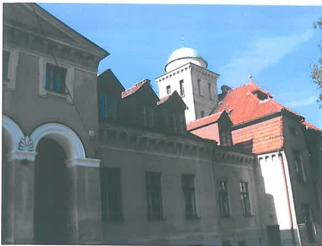
Część mieszkalna pałacu z wieżą zakończoną kopułą obrotową
